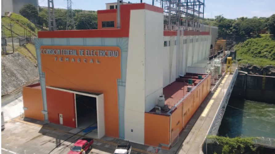
▲ Casa de força
