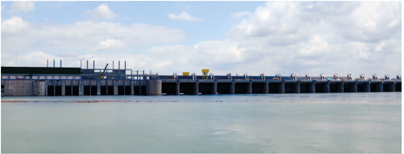
▲ UHE Pimental - vertedouro
