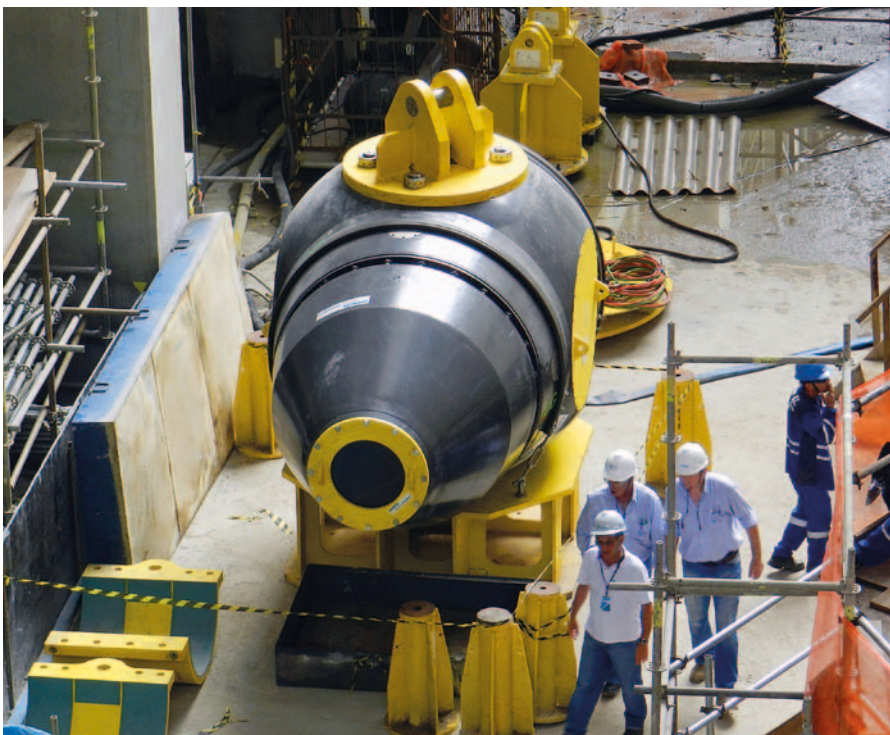
▼ Instalação do rotor Kaplan em Pimental
