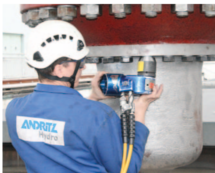
▲ Preparativos para a remontagem
