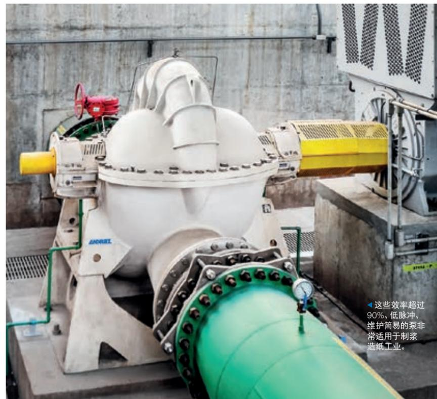
▲ 这些效率超过90%、低脉冲、维护简易的泵非常适用于制浆造纸工业。
