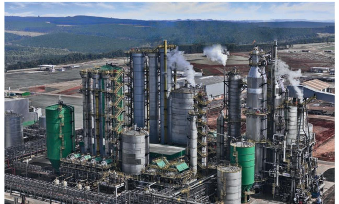
▲安德里茨为工厂交付两条浆线：一条110万吨/年阔叶木浆线和一条40万吨/年针叶木浆线。大部分针叶木将被用于绒毛浆生产。
