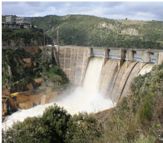
Barrage de Bemposta, fleuve Douro
