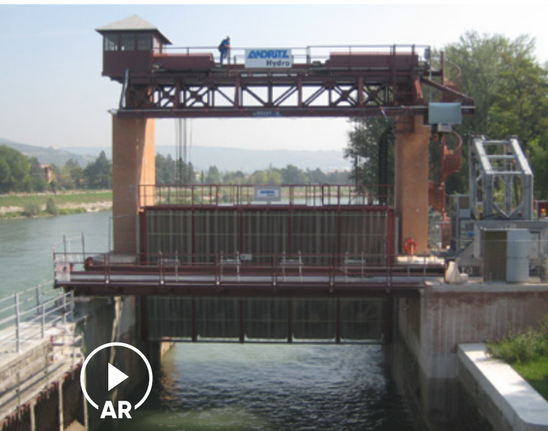
Barrage de Chievo, fleuve Adige, Vérone, cinq unités StrafloMatrix
