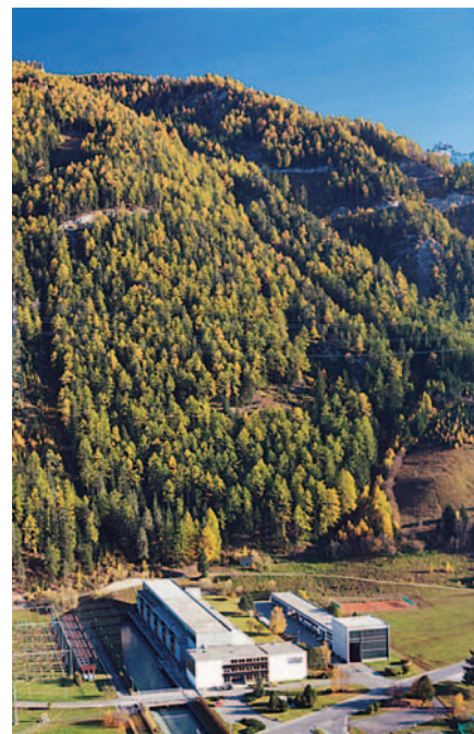
▣ Casa de máquinas y subestación
