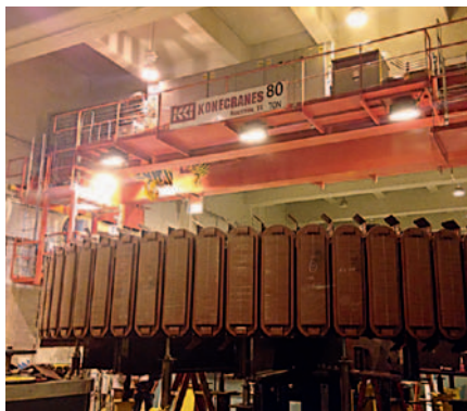
▣ Montaje del rotor
