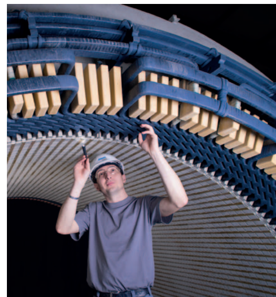
▣ Inspección del estator
