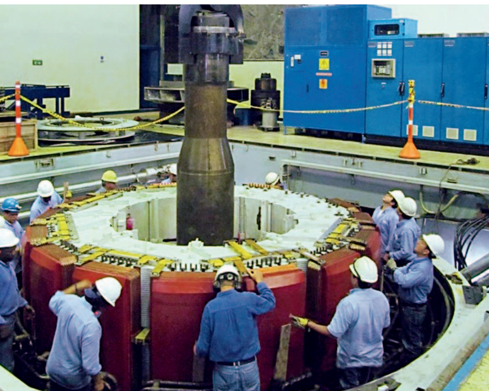
Montaje del rotor
