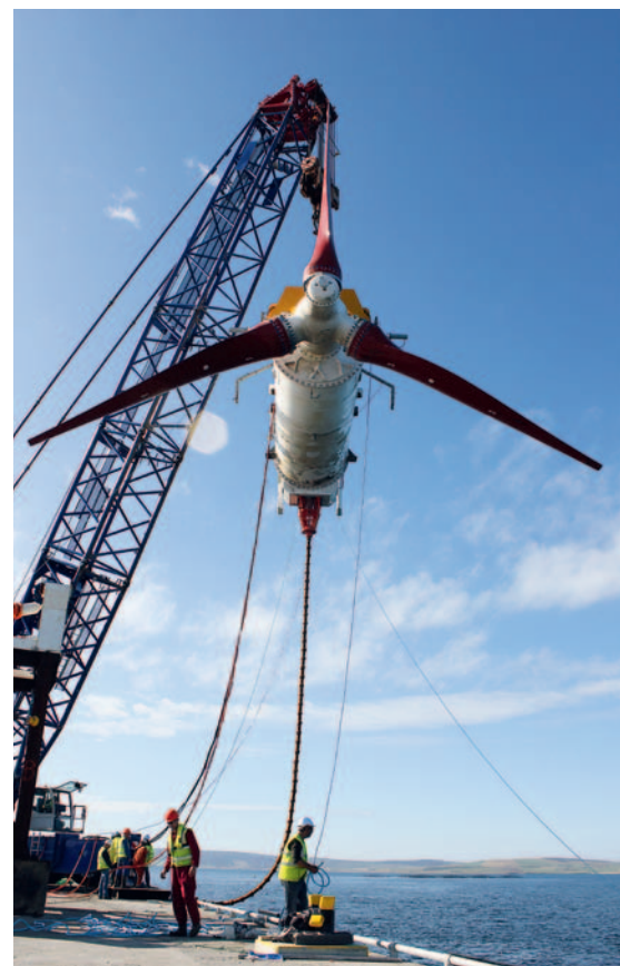
▣ Instalación de la HS1000 en EMEC
