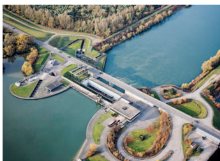
▣ Vista aérea de la central hidroeléctrica
