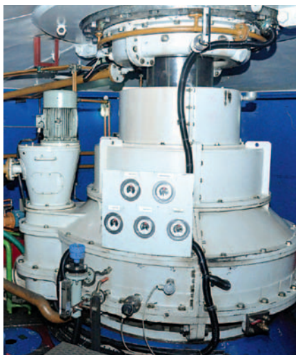
Foso de turbina después de la renovación
