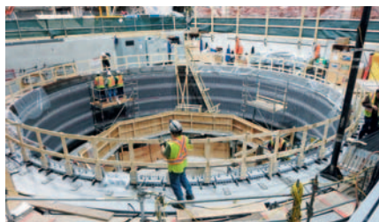
Montaje del estator
