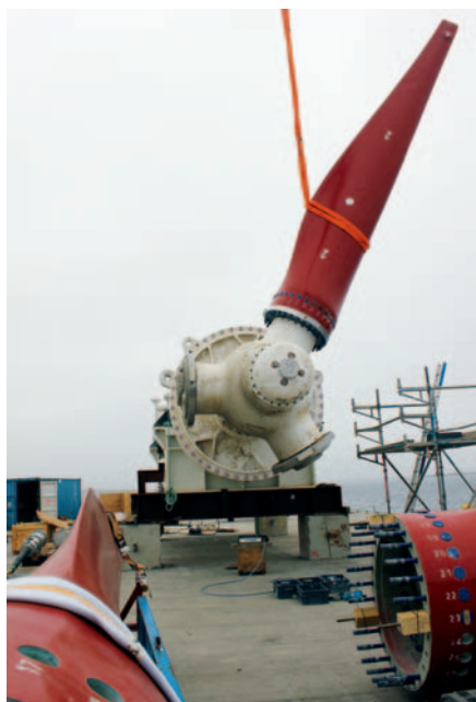
▣ Instalación de la HS1000 en EMEC, Escocia
