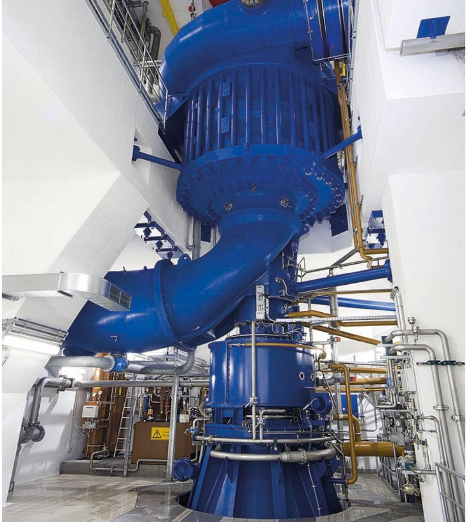
Четырехступенчатая обратимая гидротурбина
