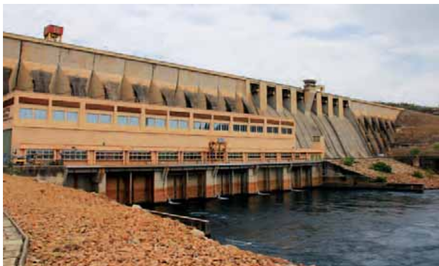
La centrale et l'évacuateur de crue
