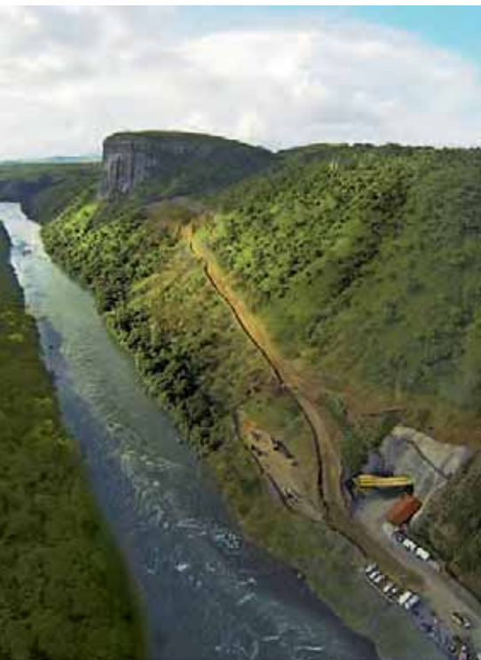
▣ La rivière Kwanza et l'accès à la future CHE de Laúca
