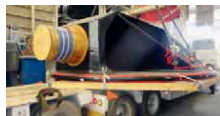
□ Préparation pour le transport du rotor de 80 tonnes de la vanne
