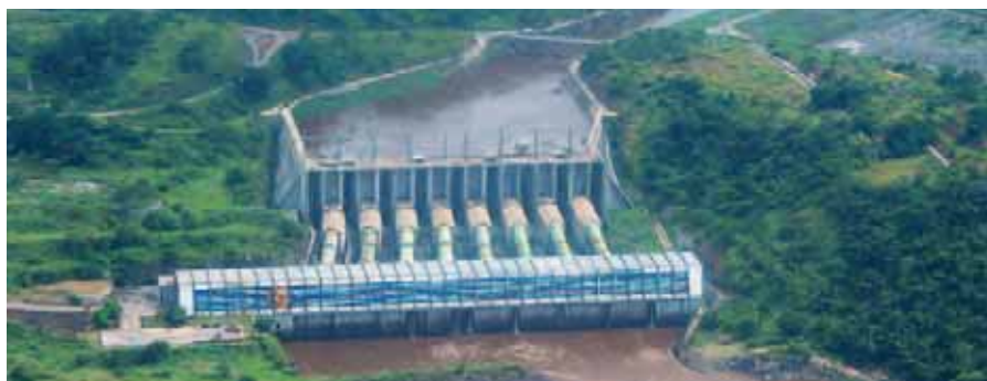
▣ Vue aérienne de la centrale hydroélectrique d'Inga 2
