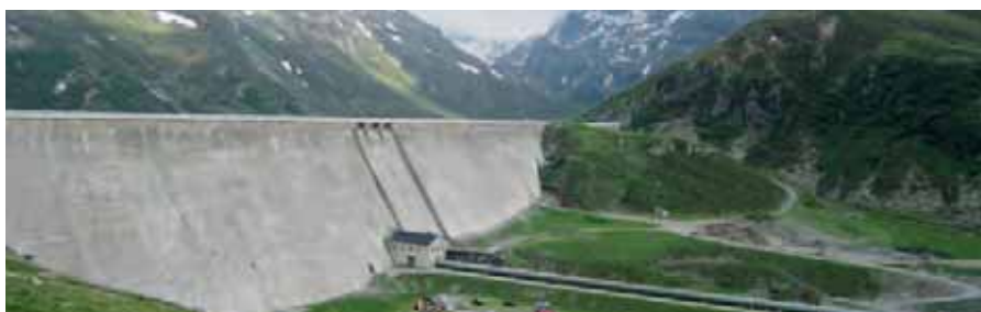
▣ Le barrage de Silvretta pour la CHE d'Obervermuntwerk II
