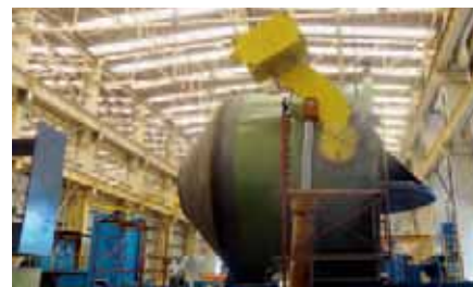
□ Assemblage de la vanne papillon dans le centre de fabrication d'ANDRITZ HYDRO au Mexique
