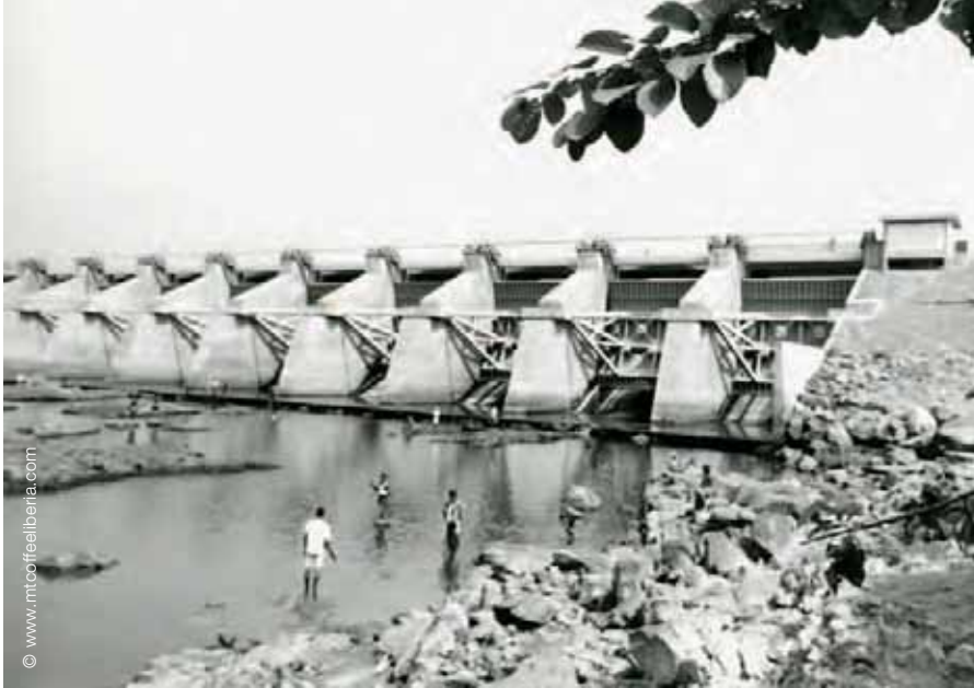
Le barrage de Mount Coffee dans son état original
