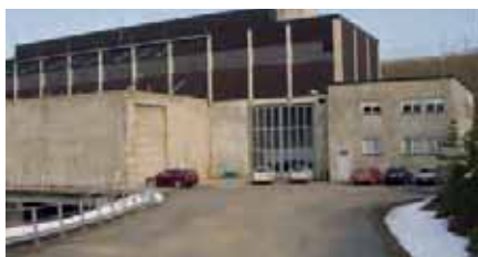
▣ La centrale hydroélectrique de Bjurfors Nedre
