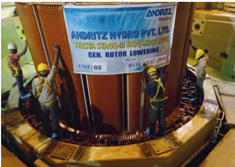
Mise en place du rotor de l'unité 2
