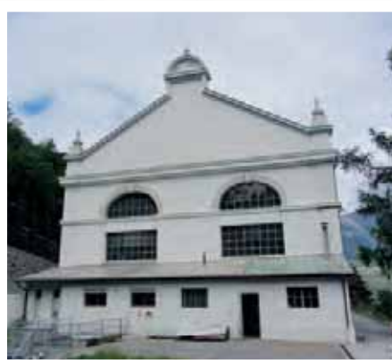
La centrale hydroélectrique
