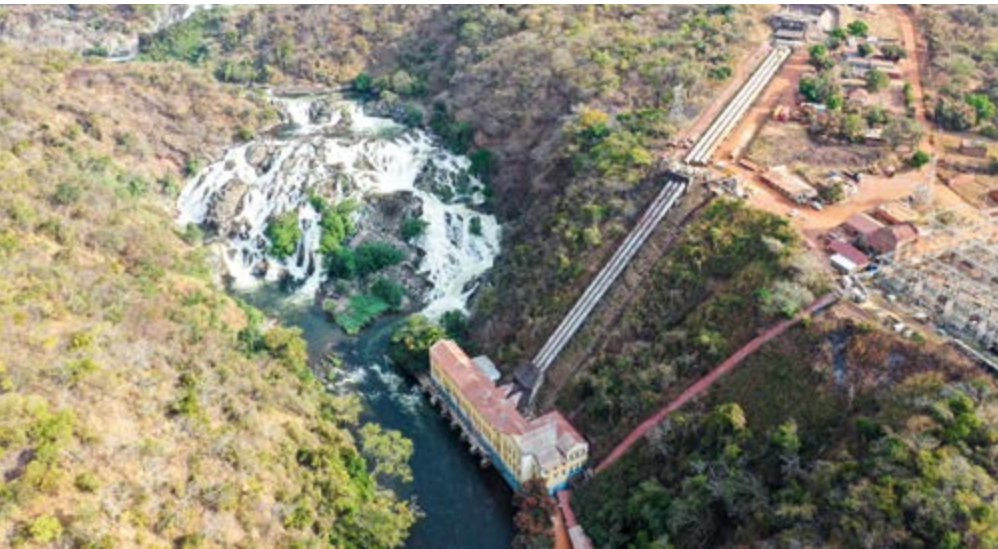
A reabilitação e modernização verão cada unidade em Mwadingusha aumentar a produção de 11,8 MW para 13,05 MW. A energia beneficiará o povo da RDC, assim como a mina de cobre Kamao-Kakula.
